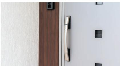
電気錠は、錠前部分を電気で施錠する機構を組み込んだドア、門柱等に使用されます。
