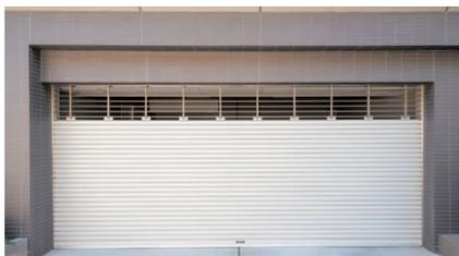
防煙シャッターは、火災発生を感知、有害な火災煙の流入を自動で遮断します。当社モータは、シャッター降下の際にフックを解除する機構に使用されています。
