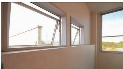
窓開閉装置は、換気、温度調節を目的に窓を電動で開閉します。
